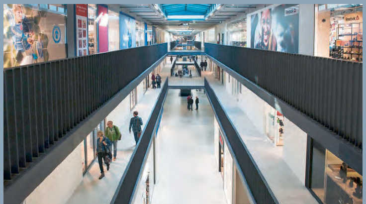
Moderne Architektur und 80 Showrooms: das O1 Ordercenter in Mainhausen.
